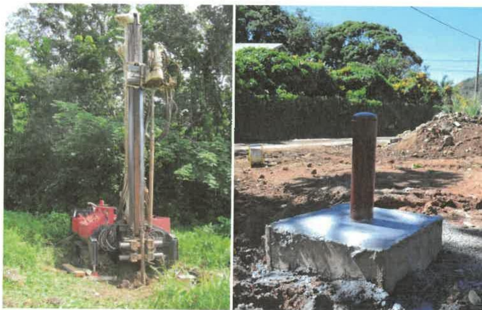
Illustrations ci-dessus : Machine de forage sur chenilles et capot de protection (crédits BRGM)
