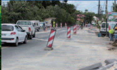
Les travaux de la Région au carrefour de Faustin Fléret.
