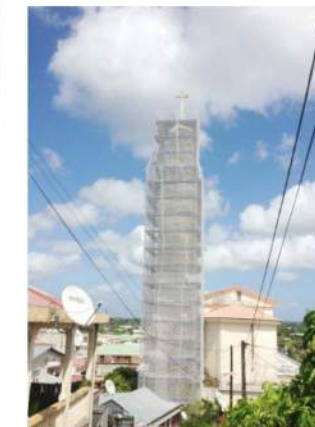
Une vue du clocher de l'église Saint-André en chantier
